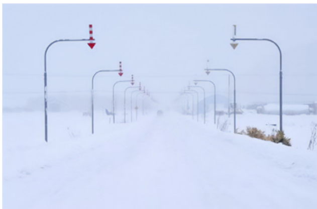
写真1 固定式視線誘導柱
